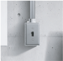
タンプラススイッチ 鉄管配管 露出ボックス ※躯体部のみ
