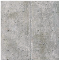
躯体現し ※解体後躯体状況による
